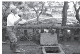
「竹通し」を長く伸ばして石管に差し入れ、内部の詰まり箇所を探す
