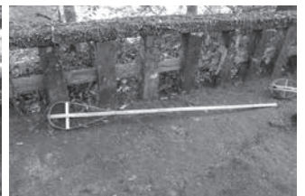
石管内部で、樹木の根の侵入箇所を調べる道具「竹通し」
