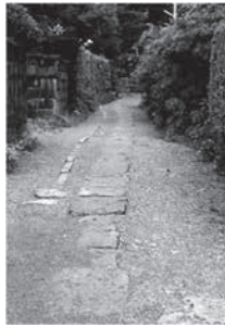
[道路の中央に伸びる水道管] (塘の上に通されたもの)
