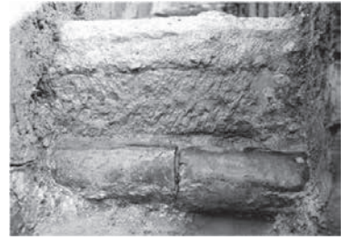
(新旧の水道管の重なっている箇所) 上：馬門石、下：松橋焼
